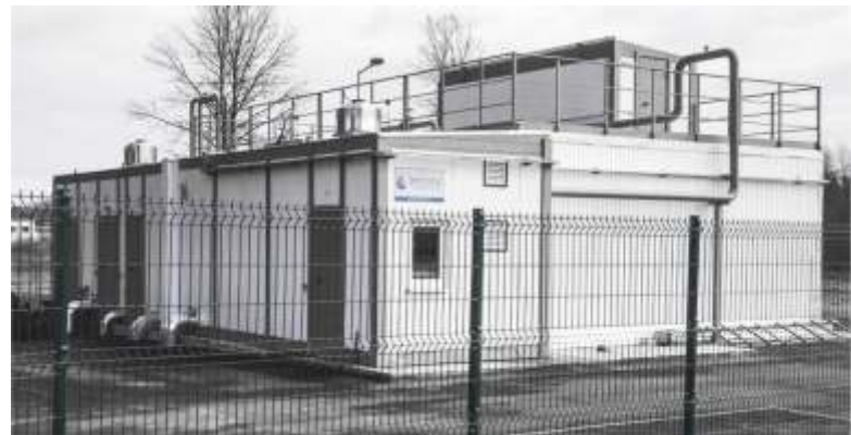
ЛОС-МБР-450 производительностью 450 м 3 /сут. СМР и ПНР. Ленинградская область, п. Сиеста
