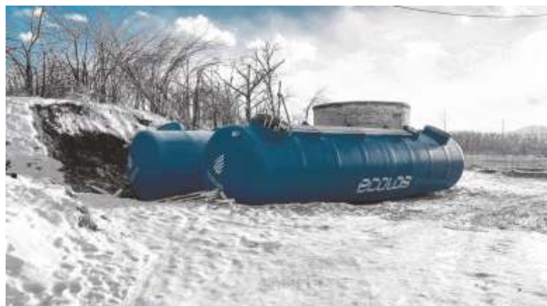
Очистные сооружения хозяйственно-бытовых сточных вод ЛОС-Р-220 производительностью 220 м 3 /сут. г. Астрахань
