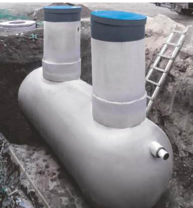
Станция ЛОС-БИО производительностью 15 м 3 Поставка и монтаж. с. Ивановское
