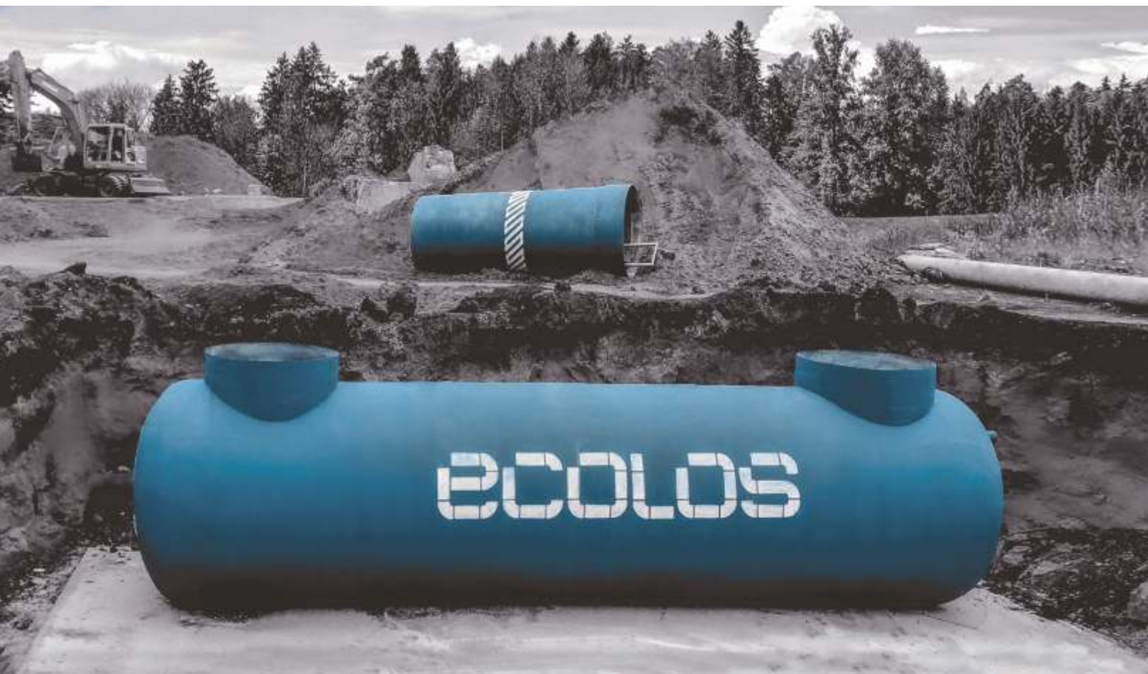
Монтаж станции ЛОС-БИО производительностью 30 м 3 . г. Тюмень
